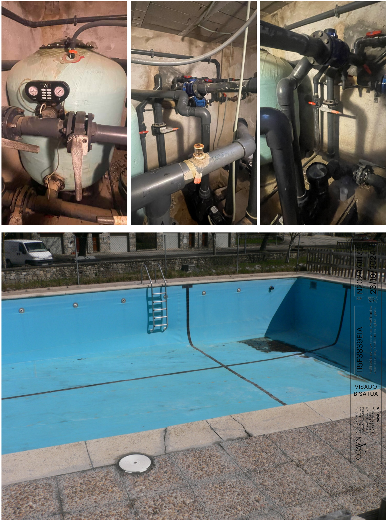
Adecuación de zona de baño de la piscina del Camping Urrutea.c/ Carretera de Gardalar S/N. Garde (Navarra) Juan Roldán Marzo + beguiristainoroz arquitectos
